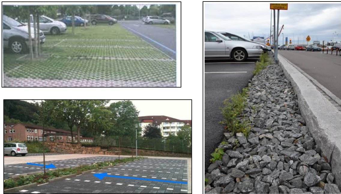
Figur 5-5. Exempel på utformning av infiltrationsytor, infiltrationsstråk nära parkering, tillsammans med gräsarmering.
