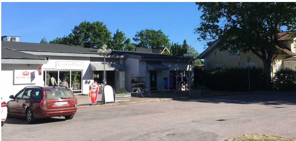
Befintlig byggnad på fastigheten, sedd från Enköpingsvägen. I bakgrund Brotorpet (privatbostad).
