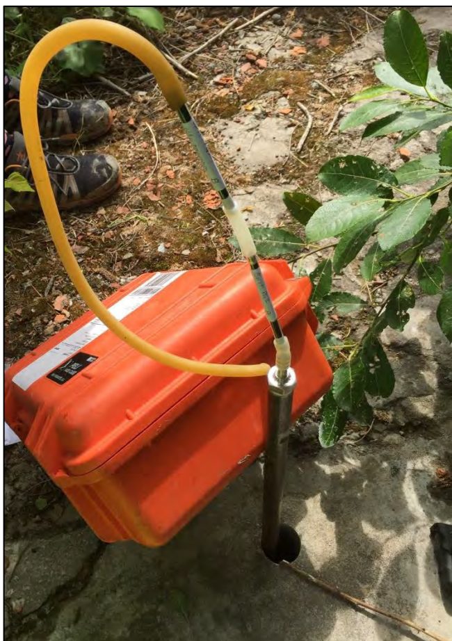
Figur 3. Foto av porgasmätning SW17_PG2 i hål borrarat för betongprov 4 (btg 4).
